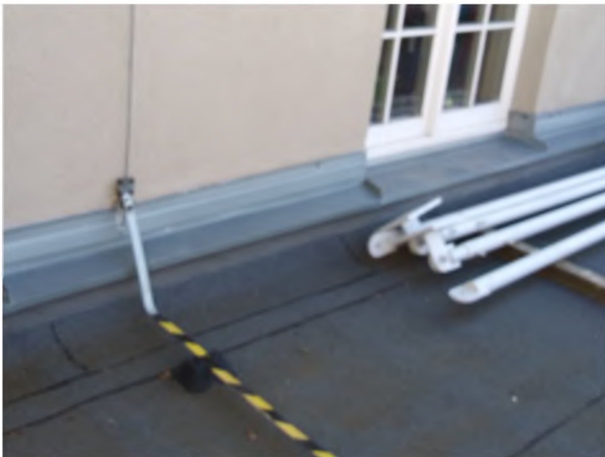
Fot. 6 – miejsce na centralę wentylacyjną na dachu
